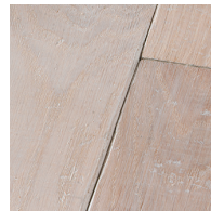
PA 14 plancher du boulanger
